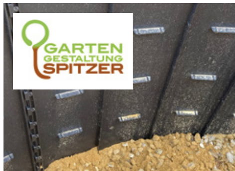
Wurzeleitleitplatte eingebaut im Betonring mit Untersubstrat für Baumpflanzung
