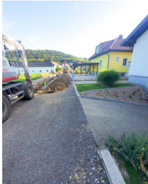
Bau Abwasserbeseitigungsanlage und Wasserversorgungsanlage in Neubach
