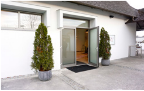
Sanierung Friedhof I und Aufbahnhalle
